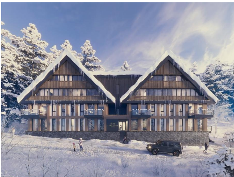
Horské apartmány Základna Špindl – ve výstavbě
