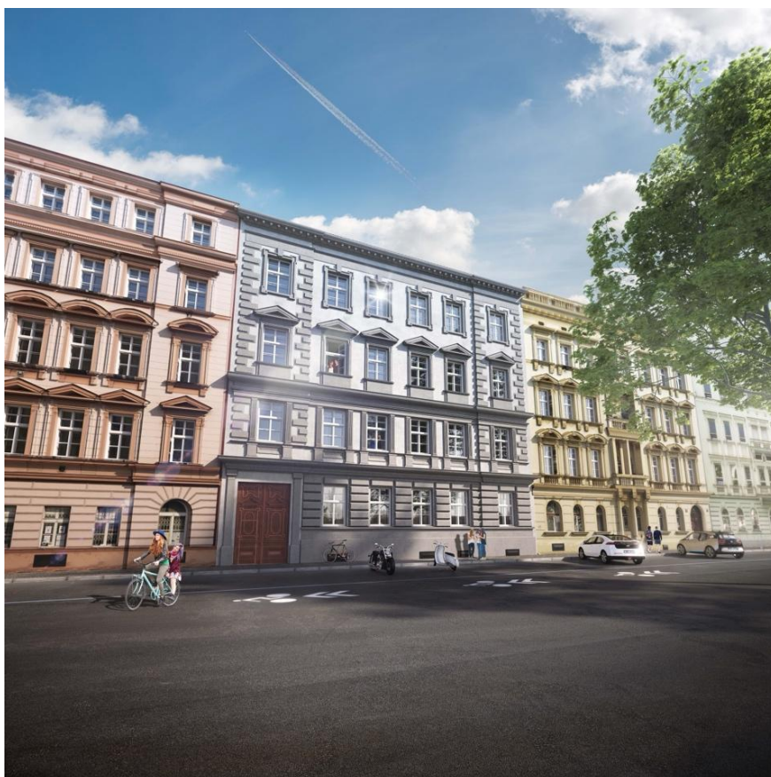
Činžovní dům Rezidence Karlínské náměstí - dokončeno (Rezidence Karlínské náměstí s.r.o.)
