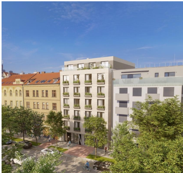
Činžovní dům Rezidence Holešovice – ve výstavbě (Rezidence Holešovice s.r.o.)
