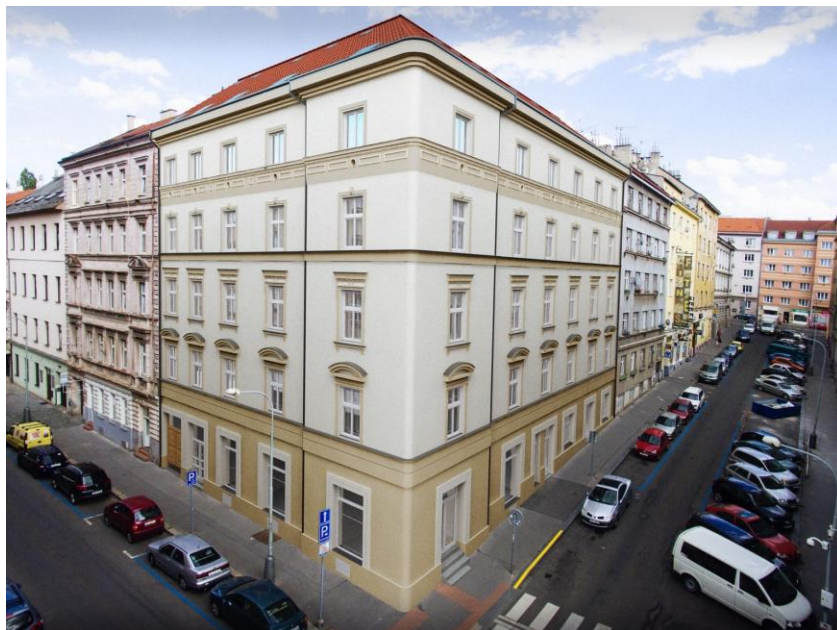
Činžovní dům Rezidence Palmovka - dokončeno
